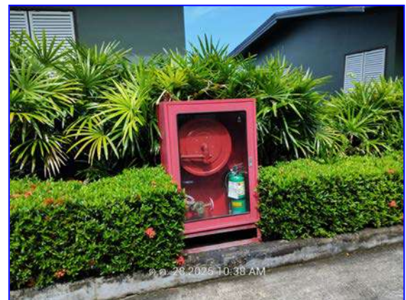
รูปที่ 2.25 ตู้เก็บสายฉีดน้ำดับเพลิง
