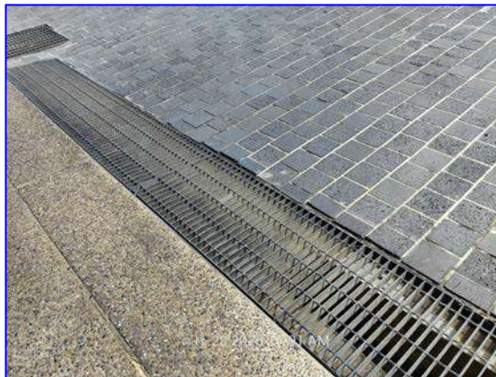
รูปที่ 2.13 บ่อพักน้ำติดตั้งตะแกรงดักมูลฝอย
