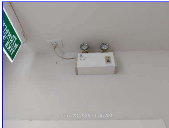
รูปที่ 2.27 เครื่องสำรองไฟ
