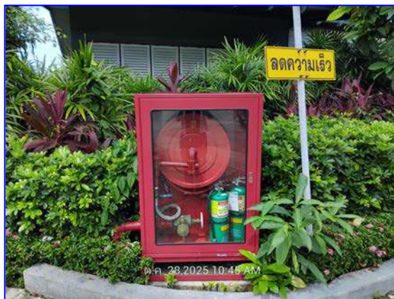
รูปที่ 2.25 ตู้เก็บสายฉีดน้ำดับเพลิง
